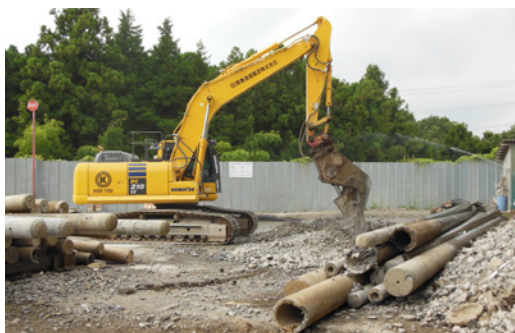
重機により破砕される電柱
