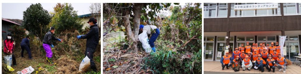
久慈川の氾濫により被害を受けた4地区でがれきりの撤去等を実施
